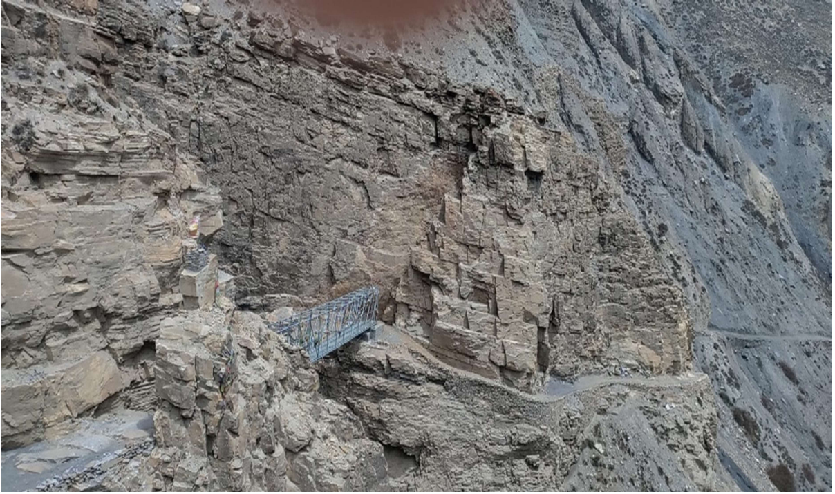
फू गाउँ जाने बाटोमा रहेको फलामको ट्रस्ट पुल
